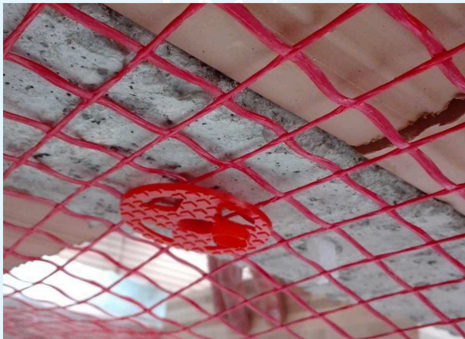
Fotografia del particolare del fissaggio al travetto in calcestruzzo.
