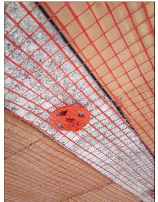
Fotografia dell'allestimento del sistema "S8" e particolare della vite "VACA" con flangia di fissaggio
