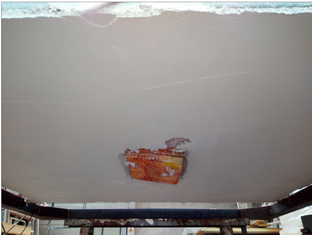
Fotografie della rottura della rete dopo la prova sul sistema "S9"
