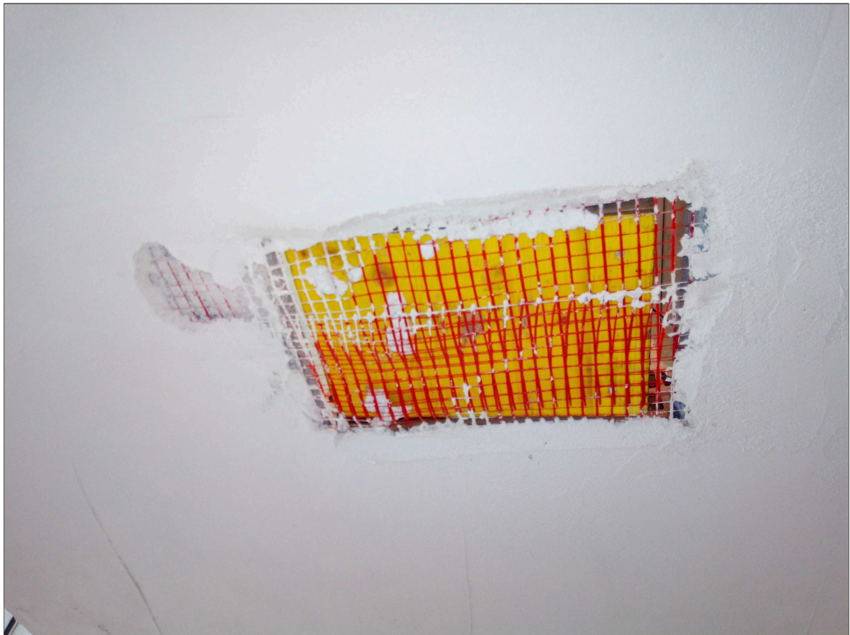
Fotografie dell'allestimento del sistema "S9" con intonaco
